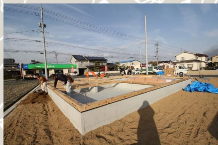
桧の防腐土台を敷いています。
