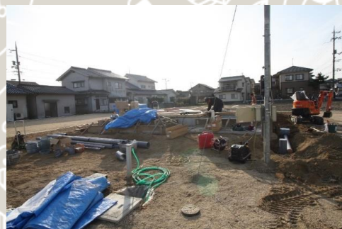
地盤調直を終えて、基礎工事が始まります。(平成30年12月1日撮影)
